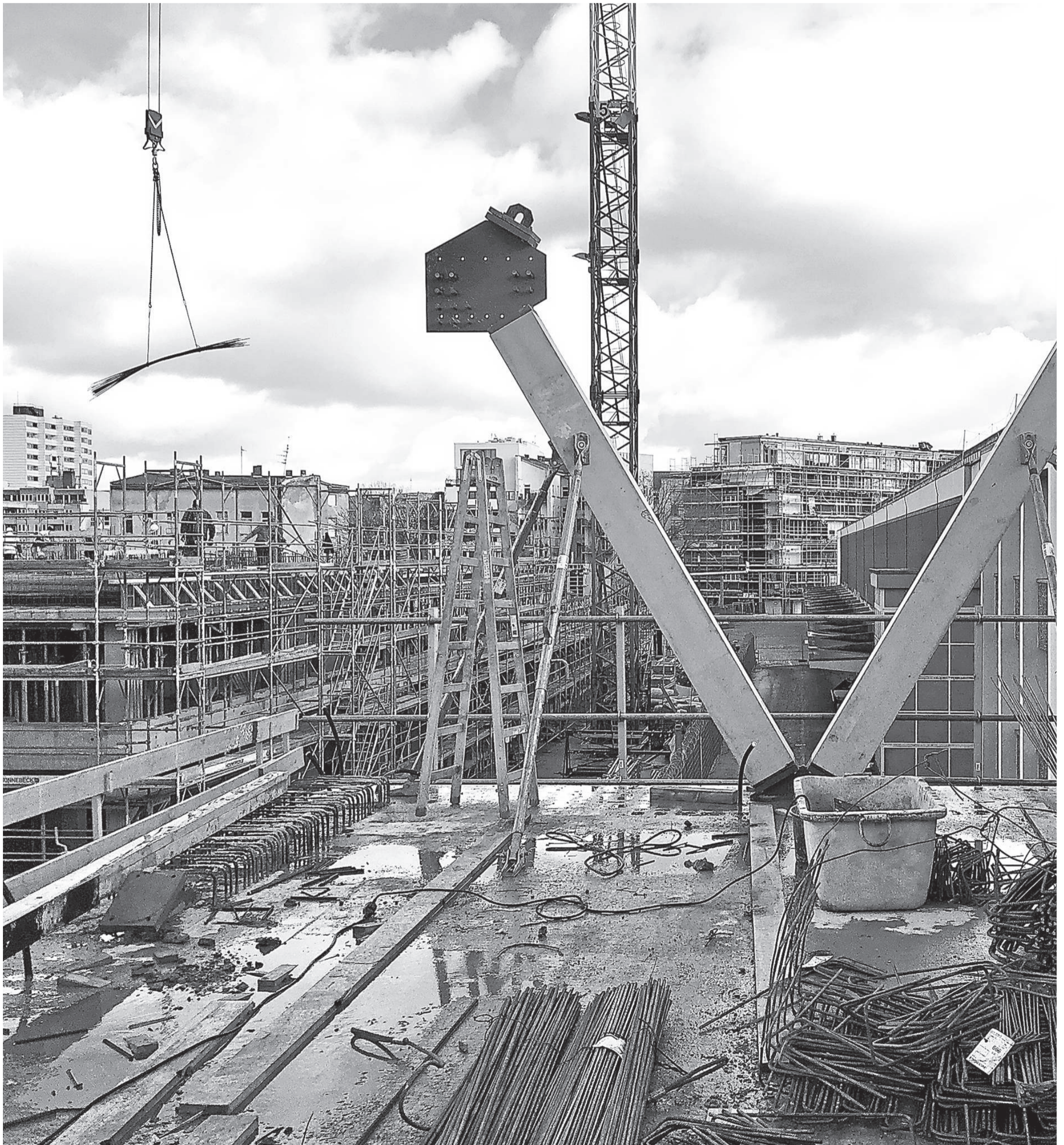
1 – Montage zweier vorfabrizierter Stützen. Bild: E2A Planmaterial: Schnetzer Puskas International
