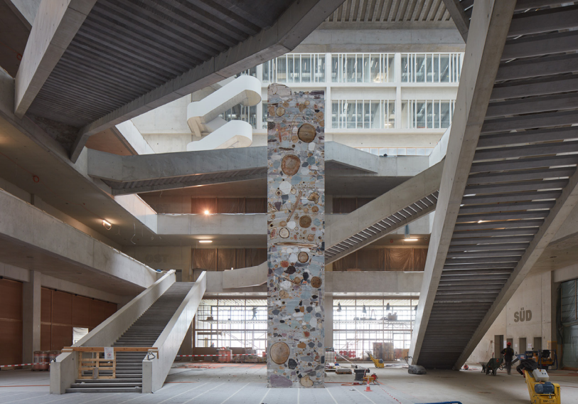
FHNW Campus Muttenz, 2018. Architektur: Pool Architekten, Takt Baumanagement
