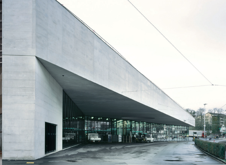
St. Jakobshalle, Basel, 2018. Architektur: Degelo Architekten / Berrel Berrel Kräutler Architekten
