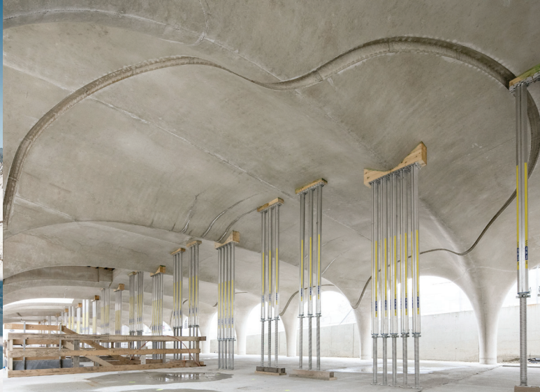
Cité du Temps, Swatch, Biel, 2019. Shigeru Ban Architects / Itten+Brechbühl AG
