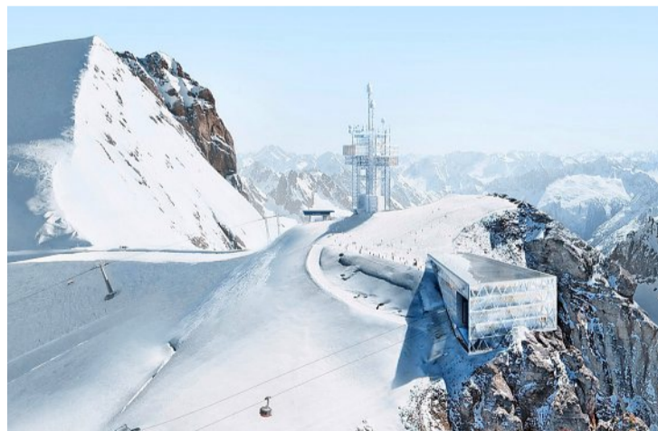
Richtstrahlurm und Bergstation auf dem Titlis. Foto: Herzog & de Meuron
