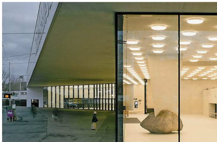
St.-Jakobs-Halle. Foto: Barbara Bühler / ARGE Degelo und Berrel Kräutler Architekten
